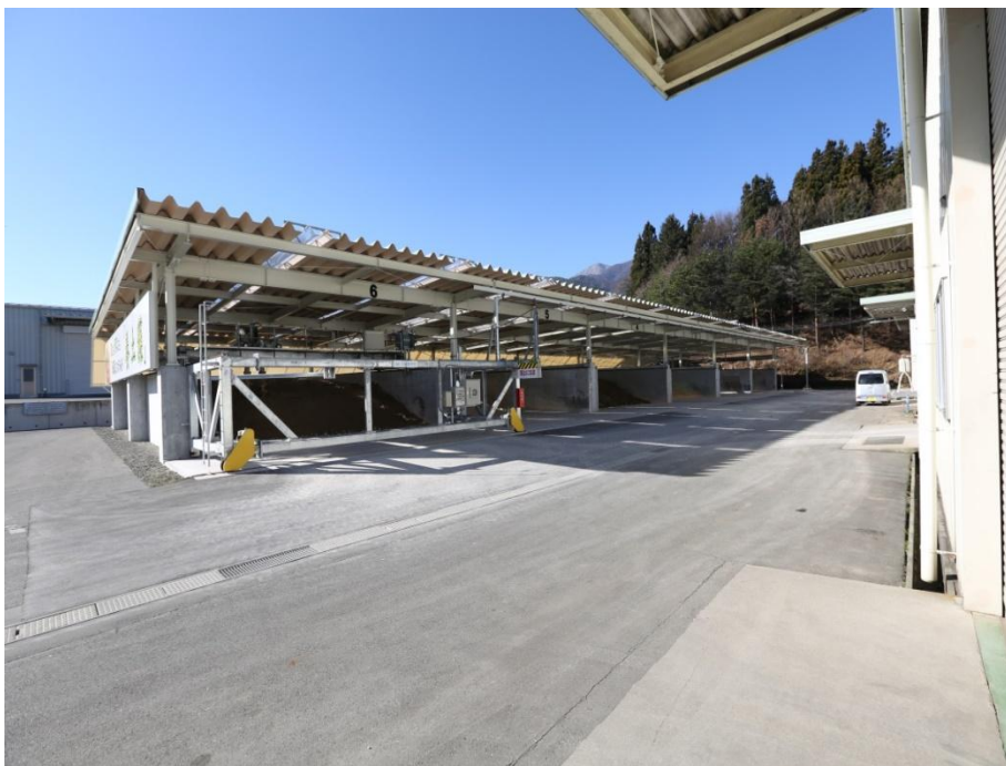
猪ノ沢工場 養土藻製造設備
